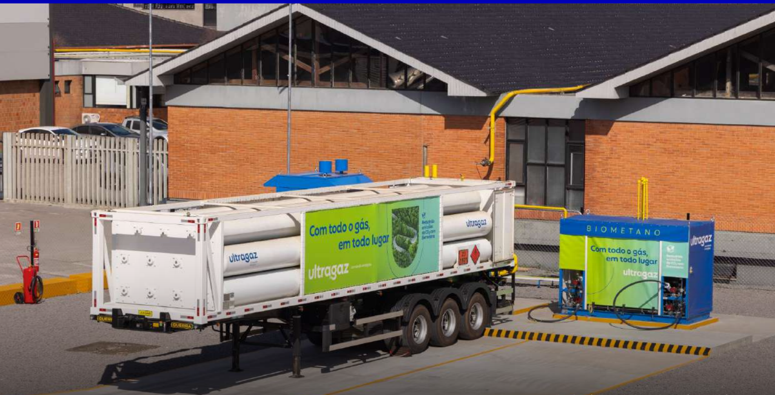
Estação de Biometano - Tramontina Multi
