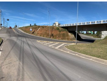
Rotonda de acceso a Carlos Barbosa
