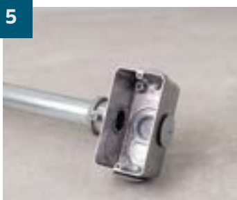
5 Glide the joint sealing for conduit until cover up the connector. Deslizar la junta de vedación para el electroducto hasta cubrir el conector.
